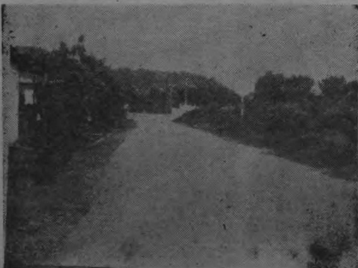
Asfaltada y ampliada la calle que va al Cementerio, se convirtió en una vía moderna y segura.
